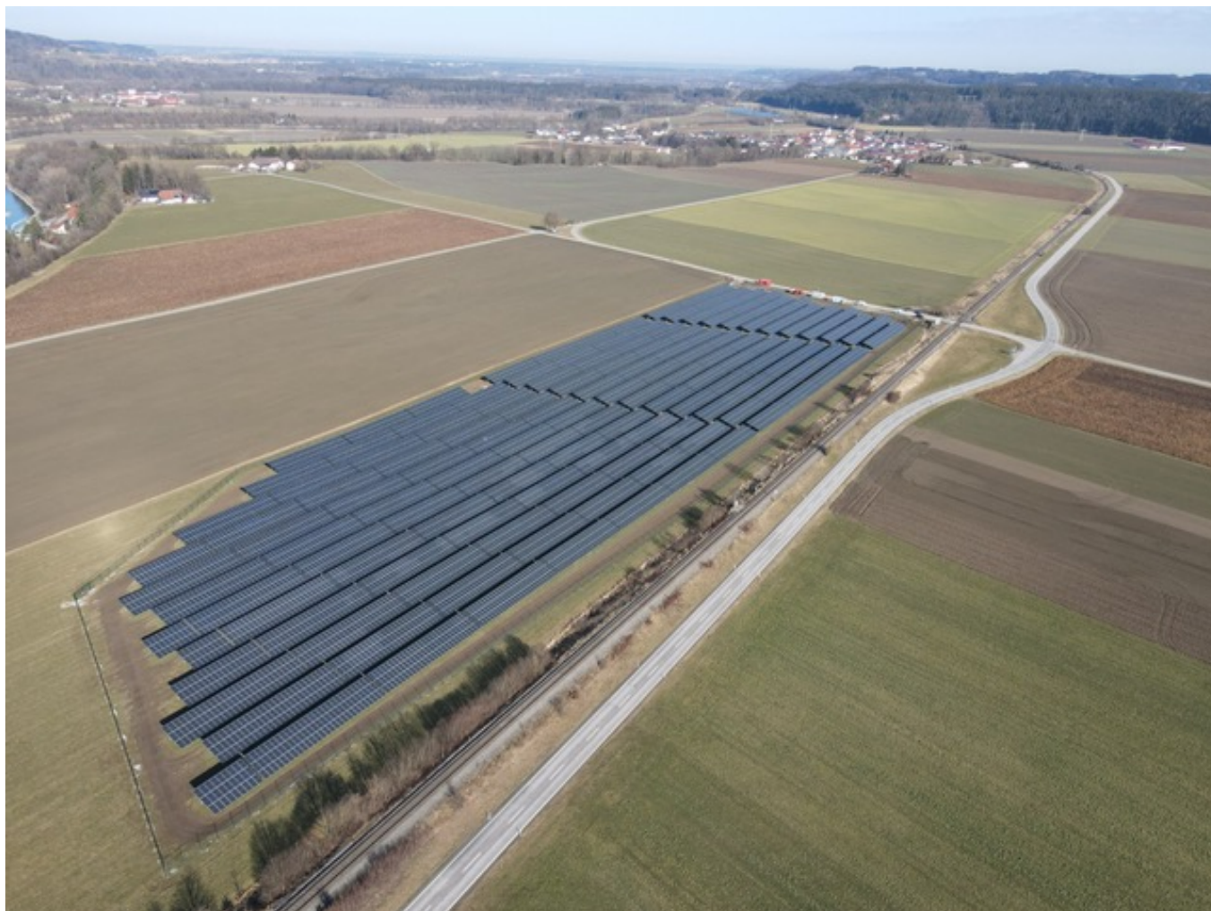
Im Herbst geht die Freiflächen-PV-Anlage der InnHügelLandEnergie eG ans Netz. Foto: InnHügelLandEnergie eG
