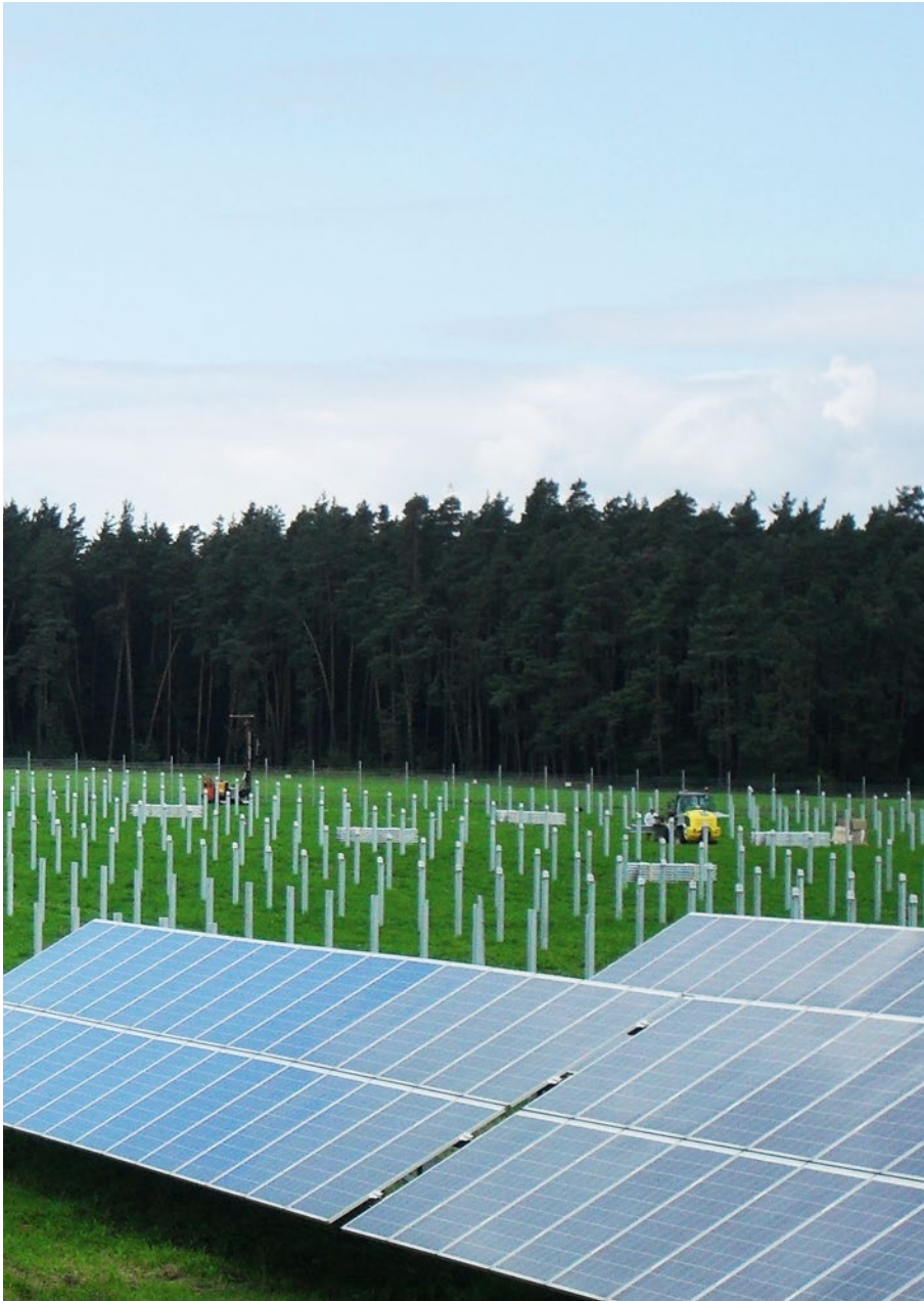
Bau des Solarparks Speinshart im September 2011. Mit diesem Projekt der Neue Energien West eG wird Strom für zirka 500 Haushalte erzeugt.
